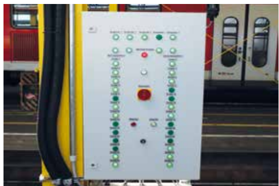
Die Überwachungseinheit zeigt mit den grünen Signallampen an, ob alle Ausschübe zurückgefahren sind und ihre Endposition erreicht haben.
