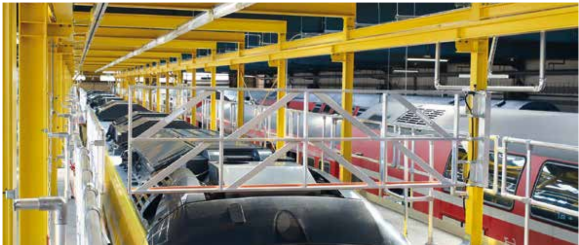
Mit Quergeländern, die an den Plattformen platziert werden können, lässt sich die Arbeitsfläche flexibel an unterschiedliche Zuglängen anpassen.
