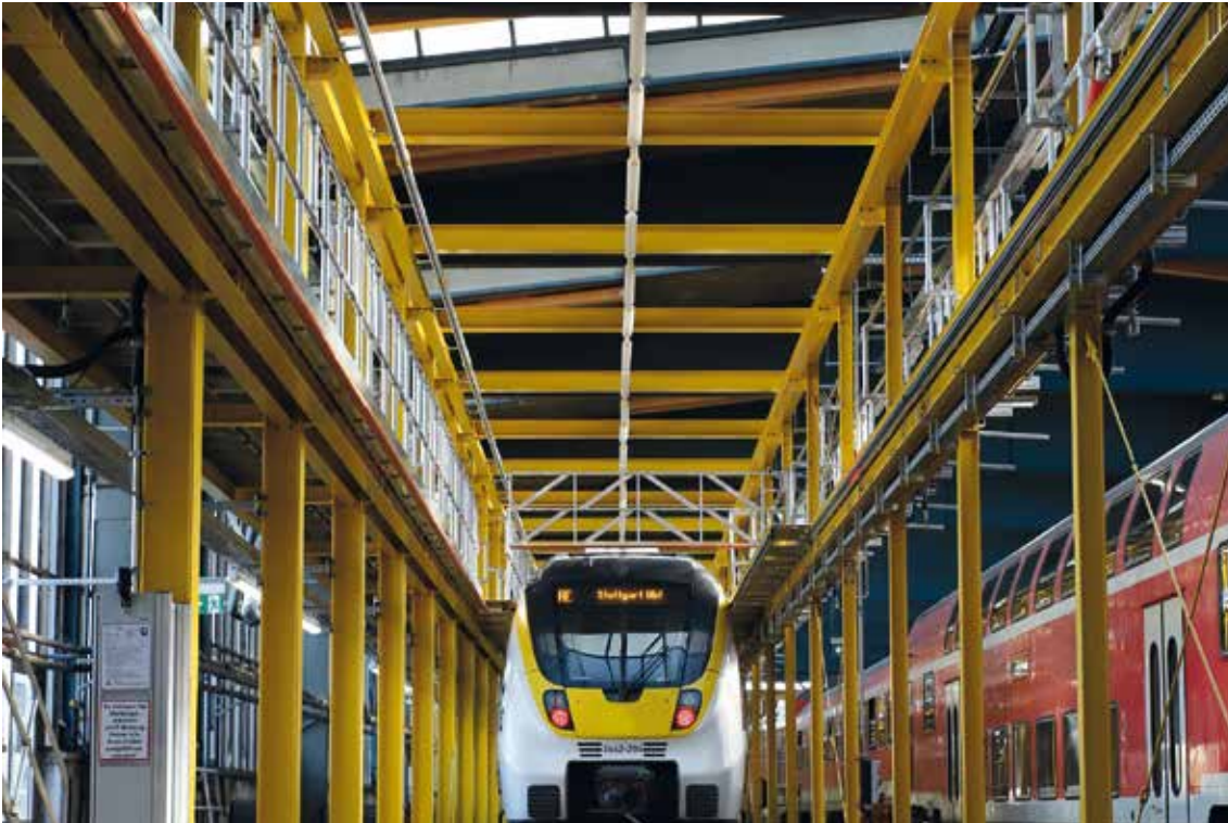
Auf 95 Metern Länge bietet der Dacharbeitsstand der GÜNZBURGER STEIGTECHNIK den Wartungsteams der DB Regio AG in Stuttgart ein Plus an Effizienz und Arbeitssicherheit.
