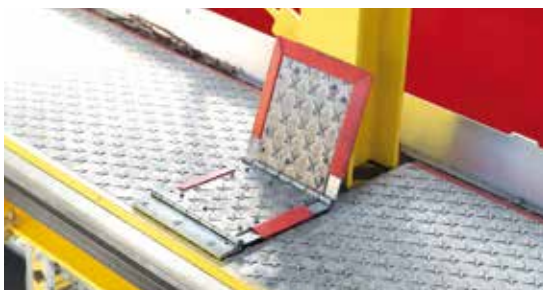
Lückenlose Sicherheit: Das gilt auch für die Plattformausschnitte an der Stahlkonstruktion.
