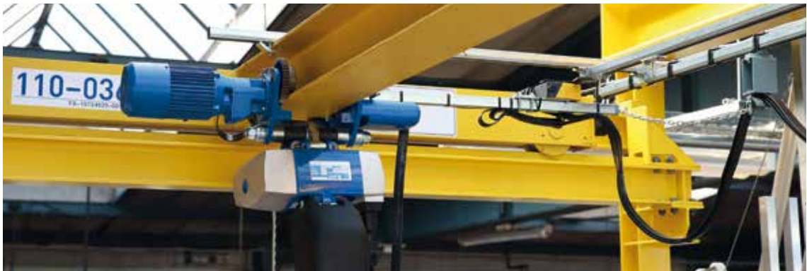
Für den Transport von Bauteilen, Komponenten und Werkzeug steht dem Wartungsteam auf der gesamten Gleislänge ein 500-Tonnen-Kran zur Verfügung.
